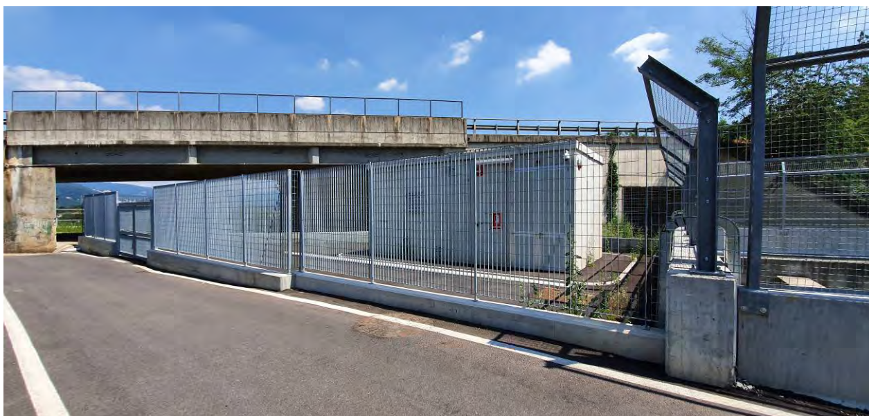
Figura 3 - Sottopasso da attrezzare (vista da via Ceresio)
